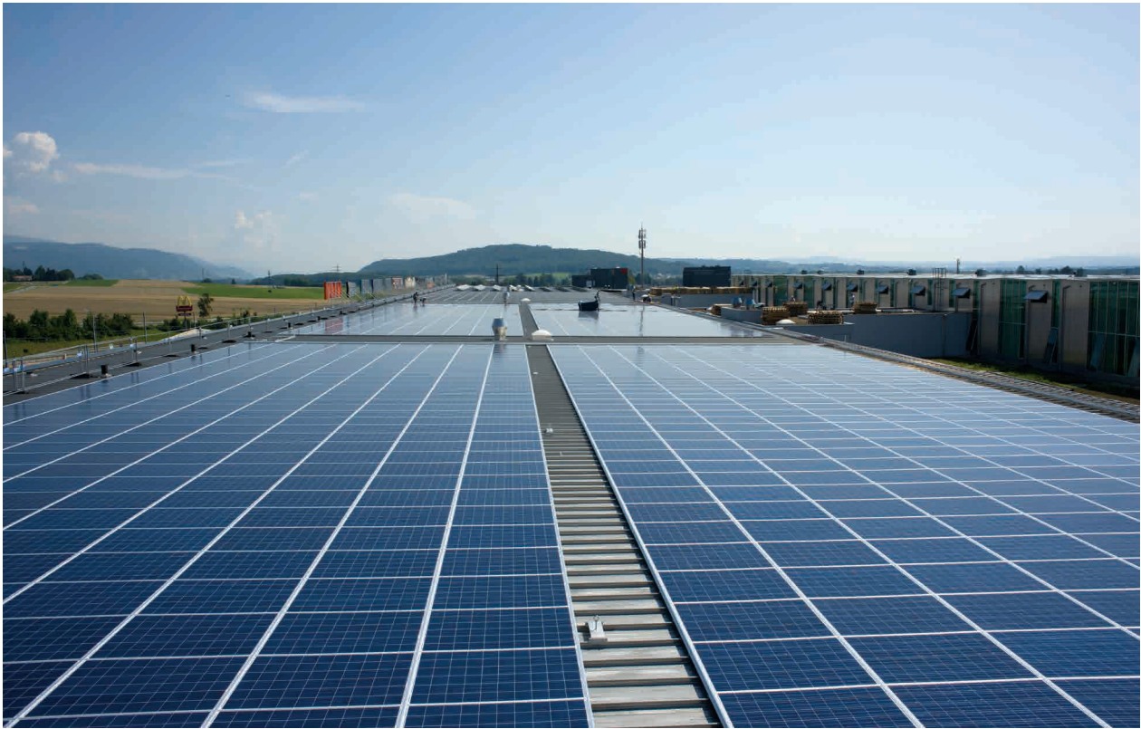
Les panneaux photovoltaïques sur le toit du parking de Marin Centre recouvrent une surface de plus de 6'300 m 2 .
